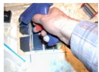
Mit eineigen Punkten Heißkleber wird nun die Glasplatte auf dem Sperrholz über den Zellen fixiert.
